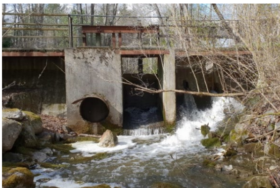
Dammen som regleras av vattendomen i Ålöström och vattenmärket kallad Tvetabergs nedre märke. 0-strecket ligger på 27.99 meter i RH2000
