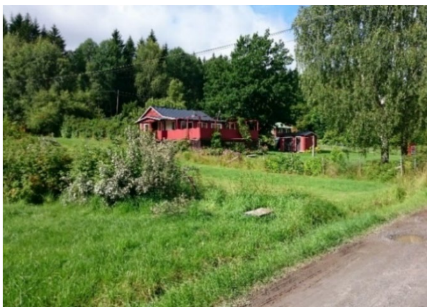
Ett av de ursprungliga fritidshusen inom Stadan. Husen har en lågmäld karaktär med enkelt formspråk. Husen är placerade på stora naturtomter.
